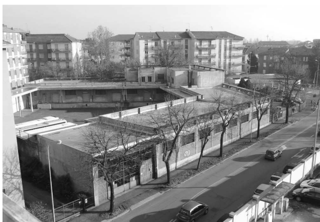
Fig. 02 - vista dall'alto dell'edificio "Pentagono"
